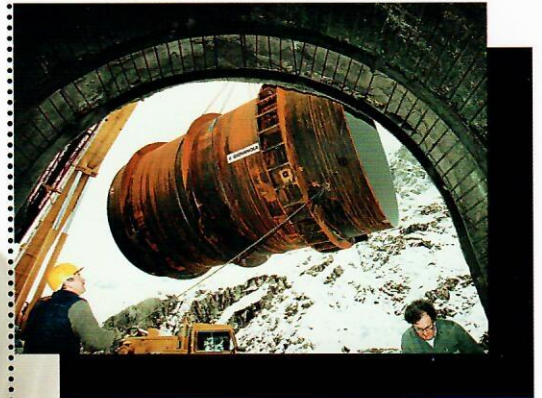
Montage d'une conduite forcée Erection penstock Montage Druckleitung
