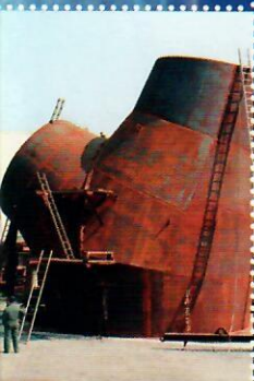
Bifurcation diam. 7,74/4,88/4,88 m Distributor diam. 7,74/4,88/4,88 m Abzweiger Durchm. 7,74/4,88/4,88 m
