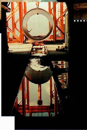
Montage d'une conduite forcée dans une galerie Erection penstock in tunnel Montage Druckleitung in Stollen
